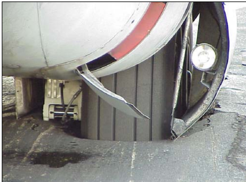
Bild 1.1 Versagen einer Flugbetriebsfläche (Trahmer 2004)
