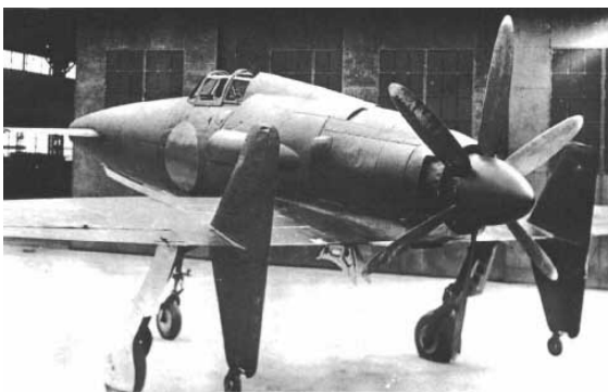
Bild 3.3 Kyusha J7W1 Shinden mit Triebwerk im Hinterteil des Rumpfes ( www.airliners.net )
